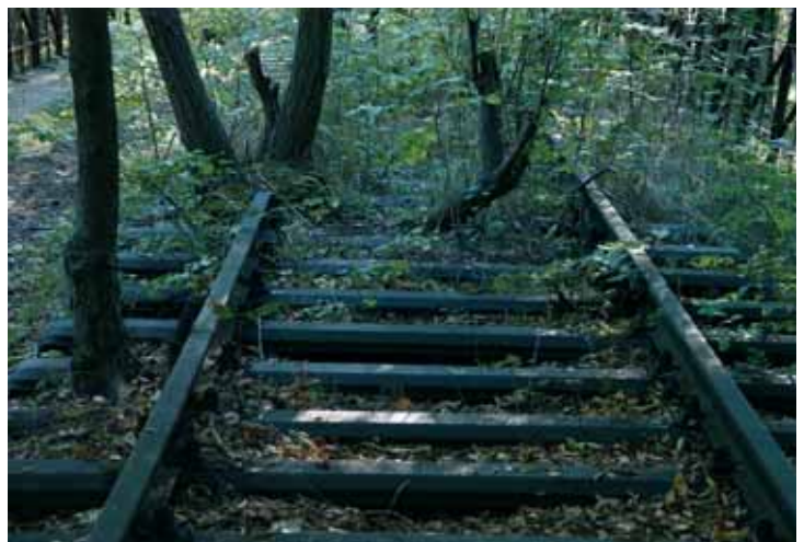
Auf der Eckerbrücke der alten Bahnlinie Harzburg-Ilseburg
