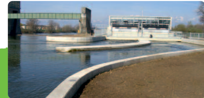
Wasserkraftwerk und Staustufe Kostheim
