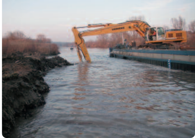
Baggerarbeiten im Zuge des Main-Ausbau bei Mainstockheim
