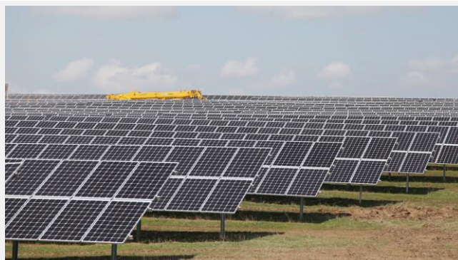
Imagen 2: Central solar de Burnoye-1 en la región de Zhambyl (Kazajistán Meridional), fuente: https://rodinaeg.com/projects/burnoye/
