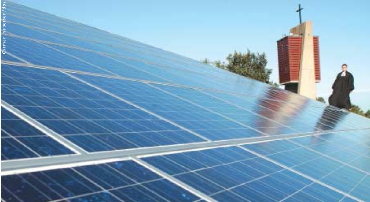
Es geht doch 400 qm Solar- anlage auf dem Dach der Martin- Luther-Kirche in Seckenhausen (Kreis Diepholz).
