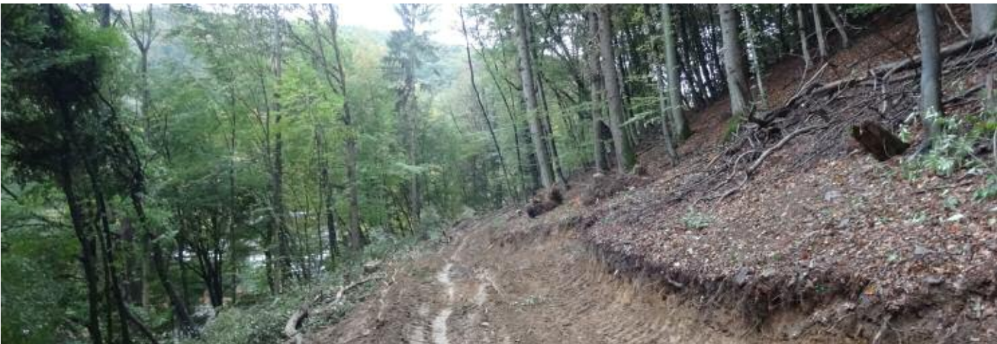
Massiver Geländeeinschnitt in den Waldboden für den Wegebau
