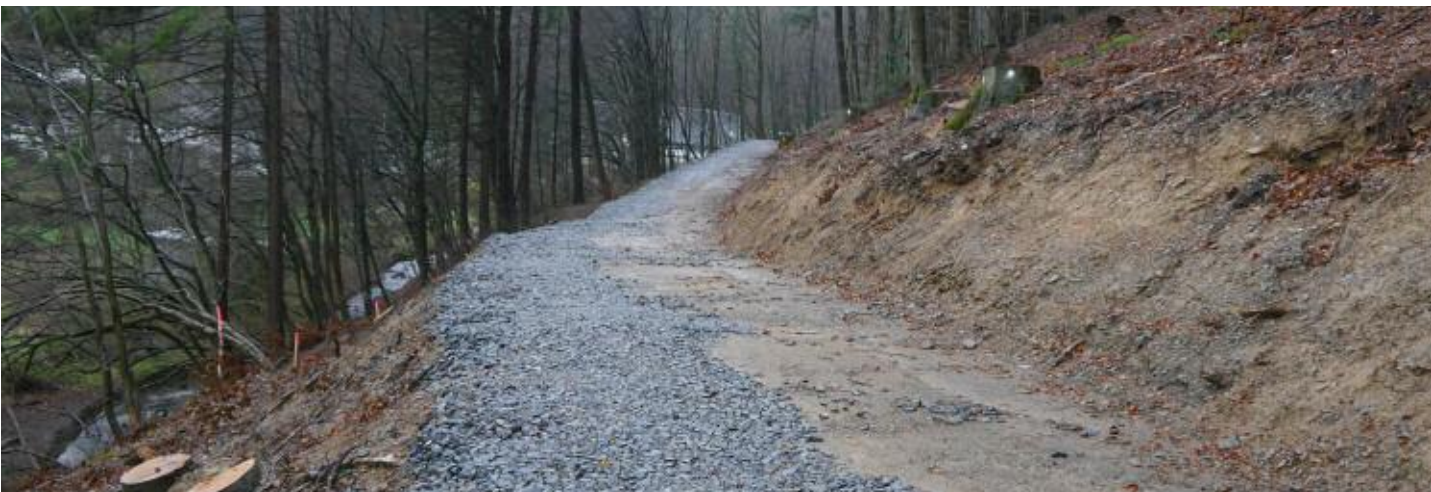
Der Waldweg danach: Boden erosionsgefährdet, Wasserhaushalt gestört, an die 400 Bäume gefällt
