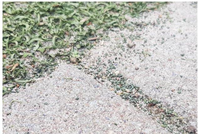
Abb. 2: Granulatverlust in die umliegenden Bereiche
